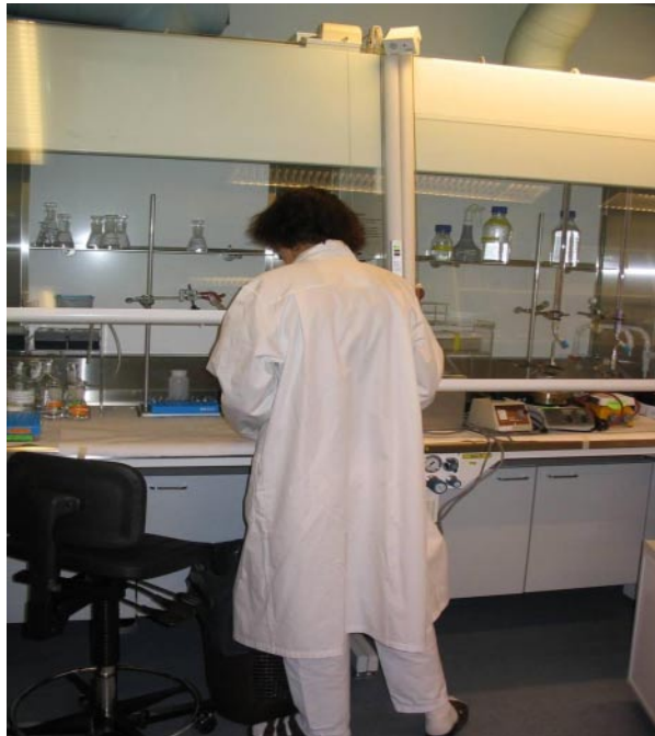
Kuva 6.9. Läsäolotunnistimella (Fanison) varustettu ilmavirtasäätöinen veto-kaappi
